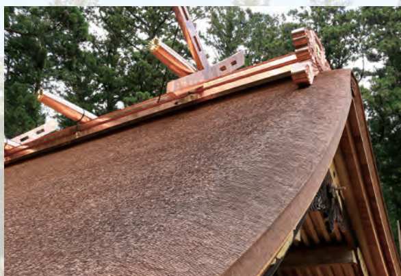
日本唯一の伝統技法「檜皮葺き」▲ 小國神社の社殿は天然素材を使い自然な循環が営まれている
